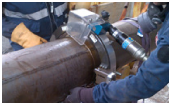
TTLW323 Станок для резки труб и снятия фаски с пневматическим приводом
